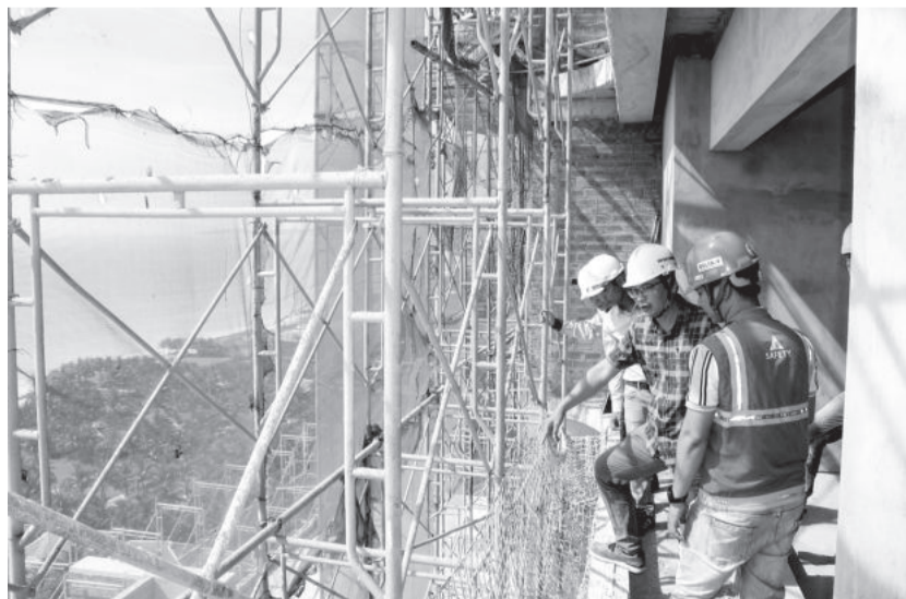
● Đoàn của Sở Lao động - Thương binh và Xã hội kiểm tra công tác an toàn, vệ sinh lao động tại một đơn vị xây dựng.
